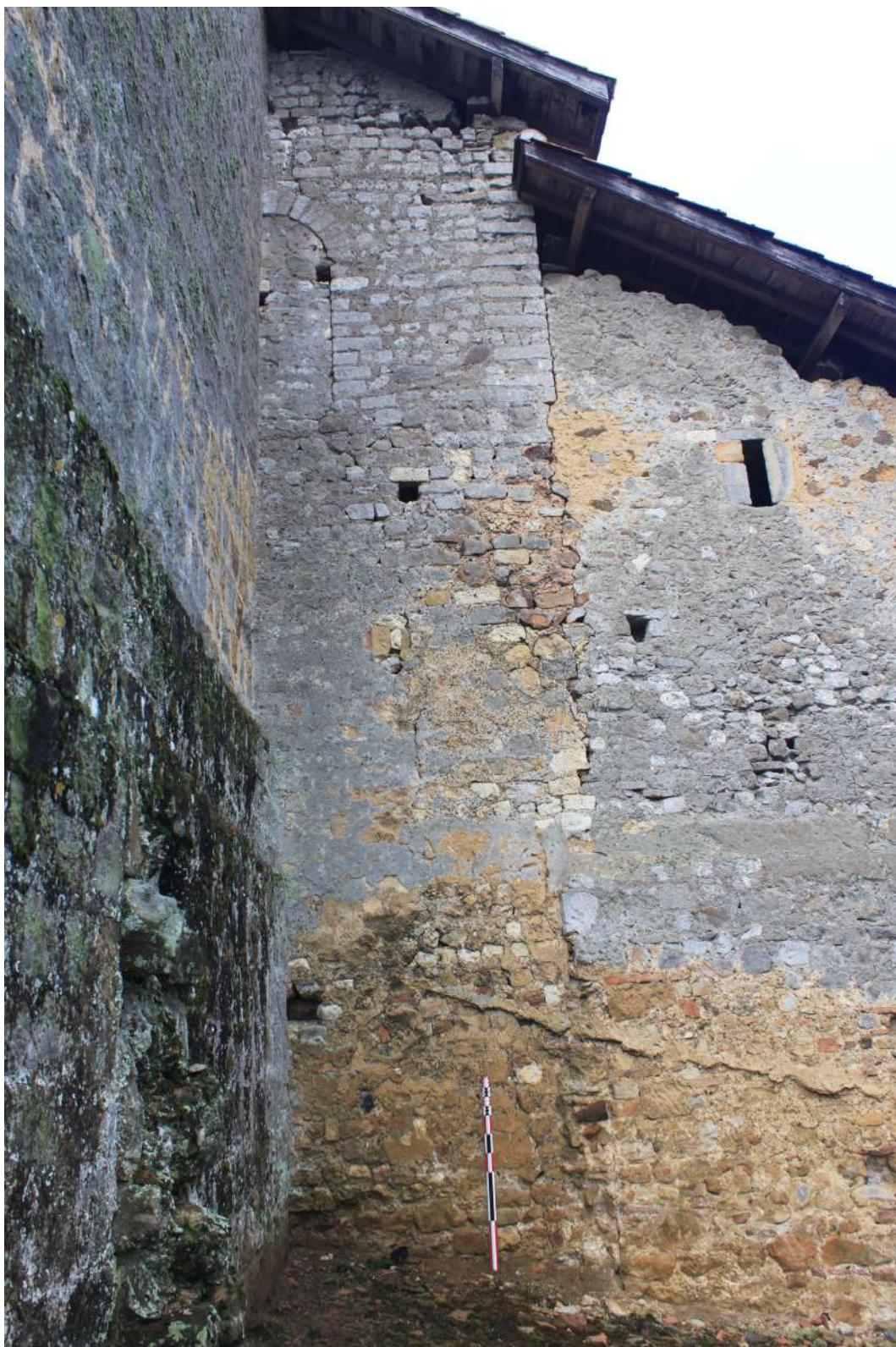
Fig. 1. Vue du mur de chevet de l'église Saint-Pierre de Sainte-Christie-d'Armagnac et d'une fenêtre bouchée, X e siècle.
